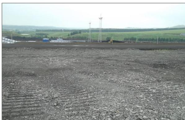
Рис. 5. Отсыпанный и спланированный отвал для закладки экспериментального полигона
